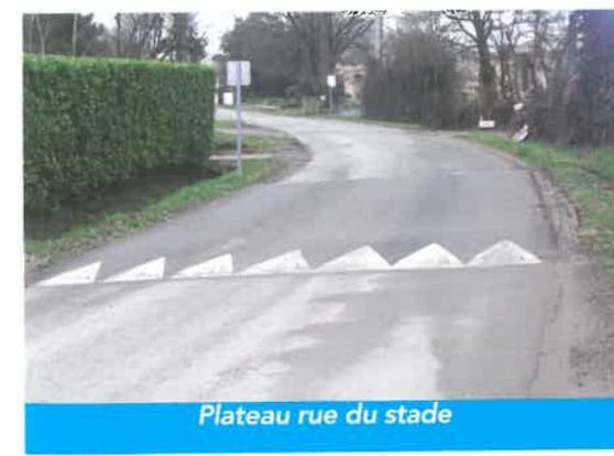
Pour des raisons de sécurité aux sorties des accès de la rue du stade, il a été nécessaire de réaliser un plateau ralentisseur afin de faire réduire la vitesse des véhicules, notamment à cet endroit où vont sortir beaucoup de véhicules avec les constructions en cours.
